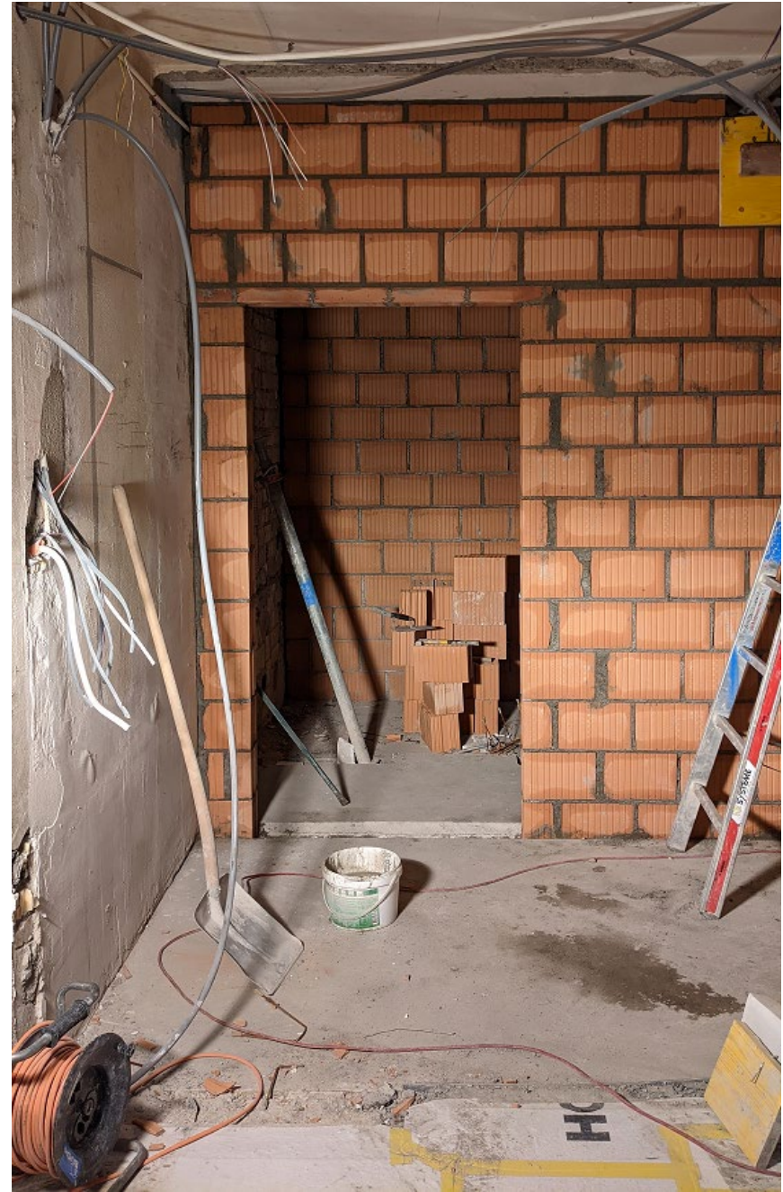
Arbeiten am IV-WC 1.OG
